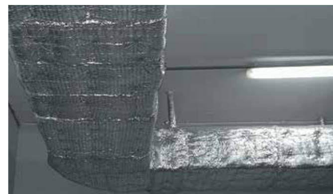
Рисунок 6. Монтажное сопряжение воздухопроводов со строительными конструкциями
